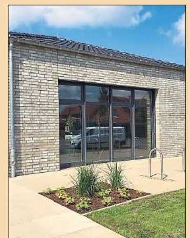
Viel Licht strömt durch große Fenster in die Turnhalle.
